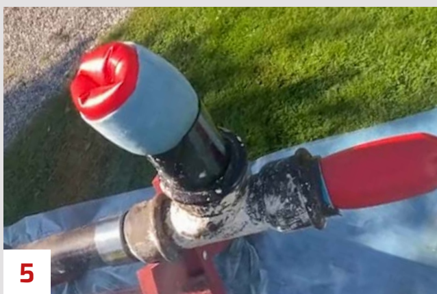
5 Etter at strømpen er stivnet, freser vi åpninger til grentilkoblinger og installerer mansjetter.
