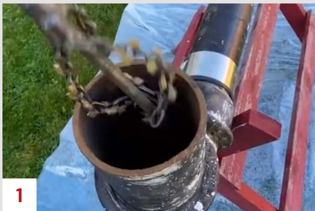
1 Rørstammer og grenrør blir først rengjort innvendig med spyling og roterende kjetting.
