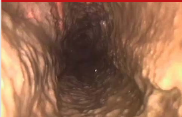
Grenrør til kjøkken, tett av fett
