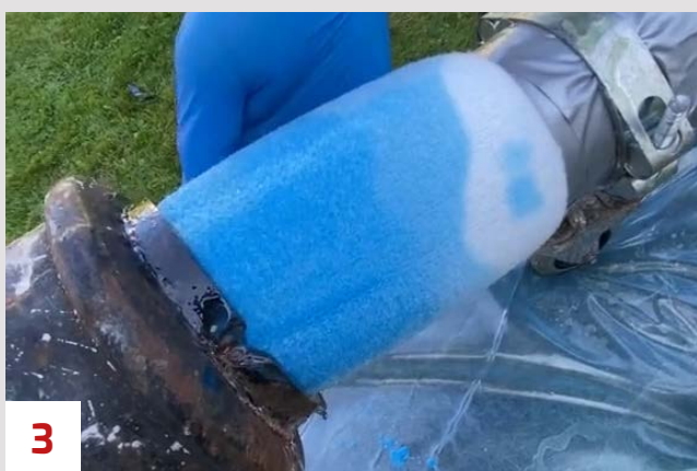
3 Strømpen vrenses inn i røret med lufttrykk, og det flytende plaststoffet den er satt inn med...
