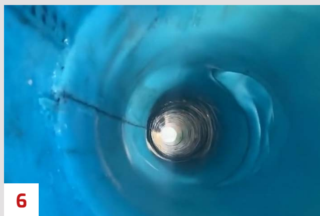
6 Mansjetter (forsegling av grenrørene) sikrer at røranlegget er helt vanntett etter rørfornyng.
