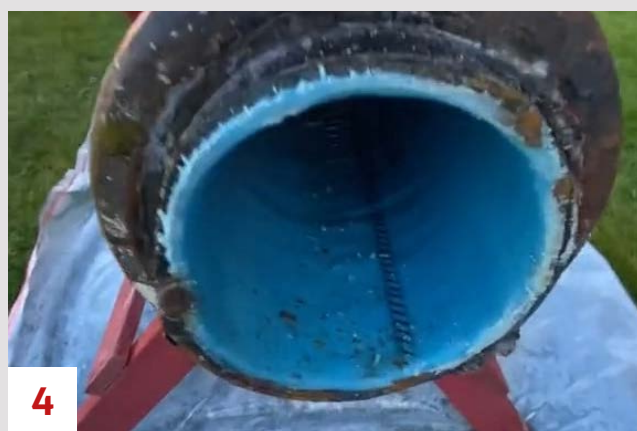
4 ...herdes med damp til et helt nytt plastrør som sitter tett inntil veggen i det gamle røret.
